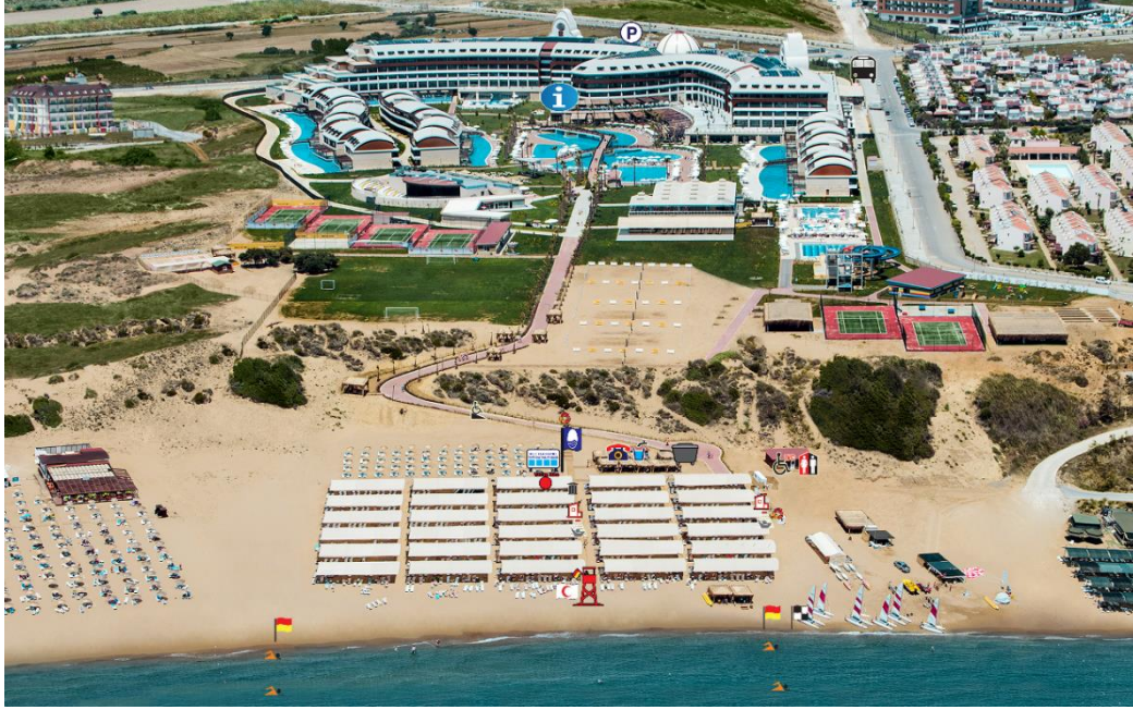
Tesis Genel Görünüm
